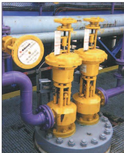
Actuadores B1940 instalados numa válvula de isolamento modelo 2200 – isolamento de tanque de armazenagem de NH<sub>3</sub>
