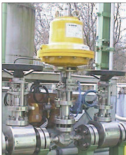
Actuador B1940 sobre uma válvula modelo 2100B - instalação de descarga de CO
