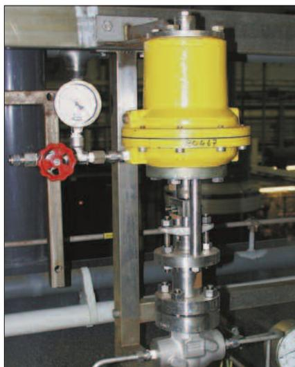
Actuador B825 sobre uma válvula modelo 2100B - isolamento de linhas de D<sub>2</sub>O/He
